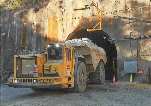
Figura 1. Fotografía del camión cargado saliendo del pórtico y escáner de volumen de carga montado en el pórtico
