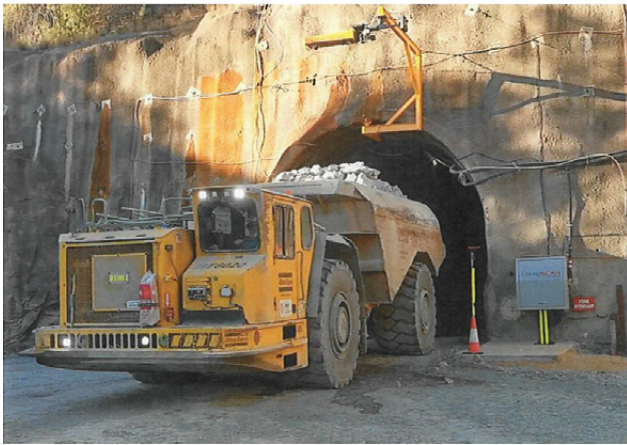
Figura 1. Foto de caminhão carregado saindo pelo portal do túnel, e o scanner de volume de carga montado na estrutura do portal.
